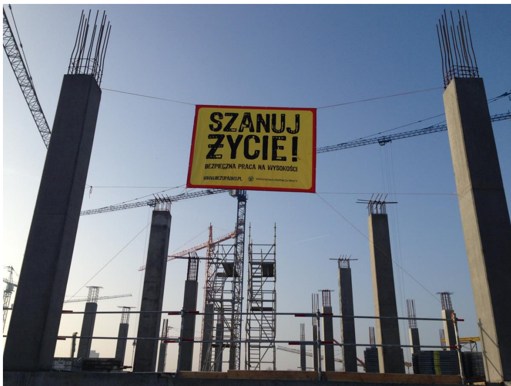
Fot. Budowa Galerii Handlowej POSNANIA w Poznaniu
