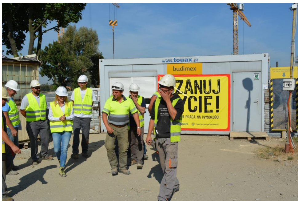
Fot. Budowa zespołu budynków mieszkalnych ul. Smolna 13 w Poznaniu
